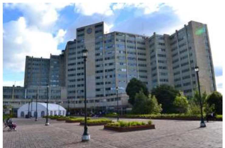
Fachada del Hospital Militar Central de Bogotá.
